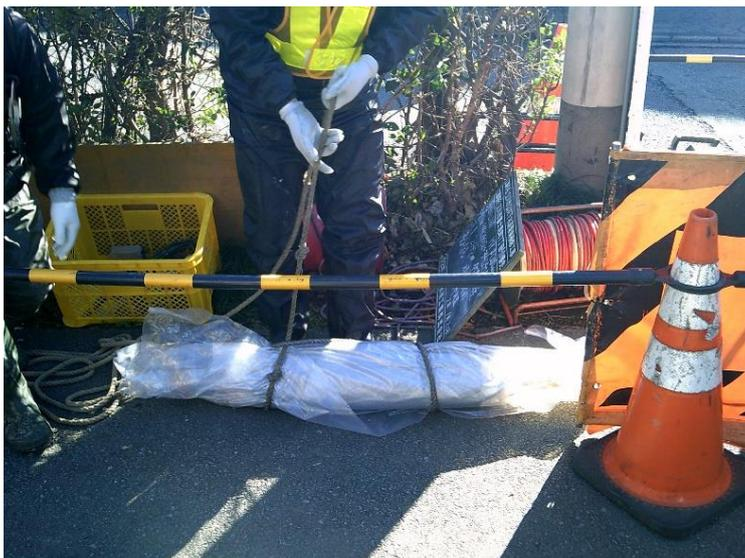
樹脂を含浸させたガラス繊維積層品を離形フィルムに巻きつけ、更にビニール等で養生してから施工箇所に搬入
