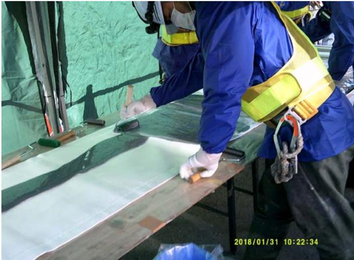
ガラス繊維積層品に樹脂を塗布し、ローラーを使って均一に含浸させる
