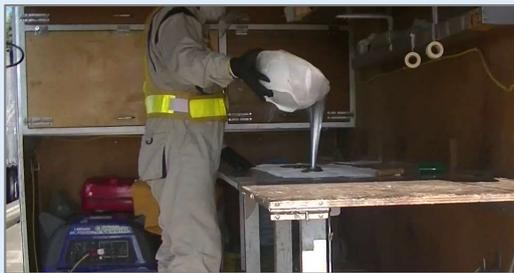
●地上作業車内でガラスクロスに樹脂を含浸します。
