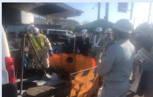
●管内での施工状況は、TVカメラから地上のモニターに出力することでオンラインで確認していただきました。
