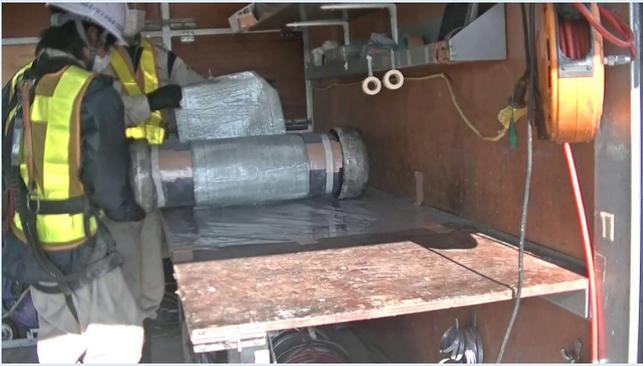
●樹脂を含浸したガラスクロスを機材に装着します。
