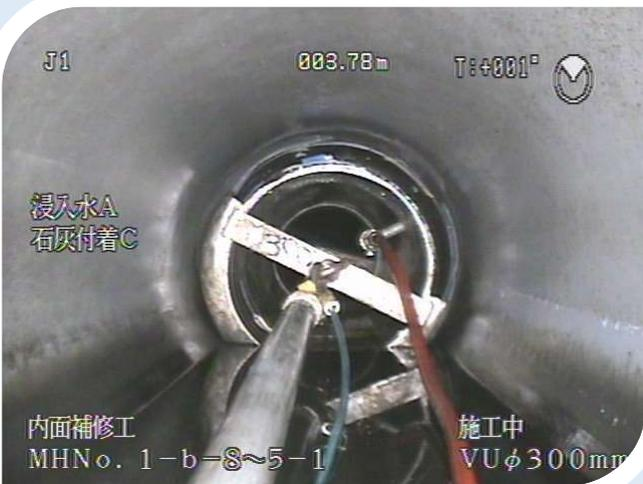
●管内カメラで位置を確認しながら機材を補修箇所に合わせます。補修箇所にセットしたらエアを送り込み、ゴムチューブをふくらませることでよりガラスクロスを管内に圧着させます。EPS工法は『常温硬化』の為このまま硬化を待ちます。硬化時間は概ね3~4時間です。(管内温度によって変動します)また、スチレン等の悪臭がなく大がかりな機械も使わないため騒音もありません。
