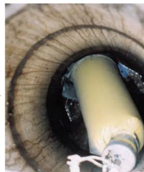
エアを充填し管内面に更生材を圧着します。
