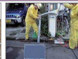
3. エアを充填し、既設管内面に圧着
