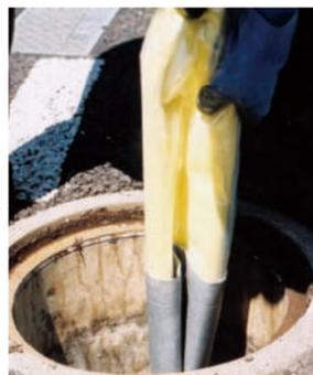
更生材を巻き付けた拡張チューブを樹から管内に引き込みます。
