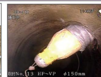
5. 拡張チューブのエアを抜き、機材を撤去
